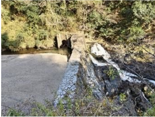
第二工場の取水用に作られた和束川の堰。
