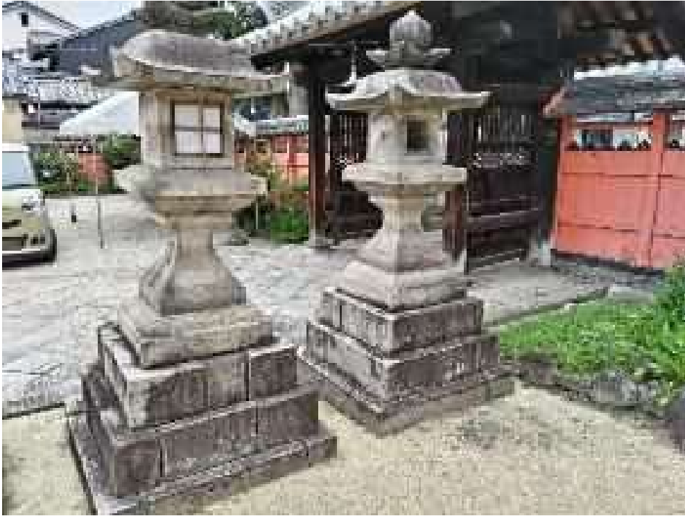
○奈良県 大和郡山市 薬園八幡神社 伊賀上野地震
