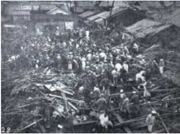
倒壊した西陣尋常小学校（「上方」46号所収）
