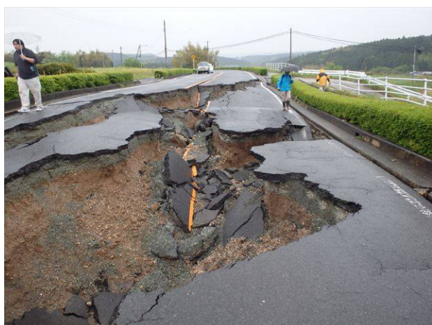
道路盛土部分は被害が大きい
