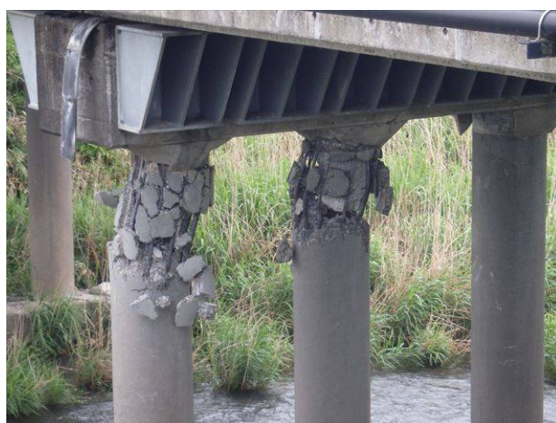
橋脚の損傷
