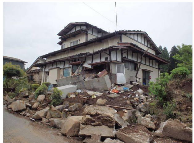
盛土部分の崩壊
