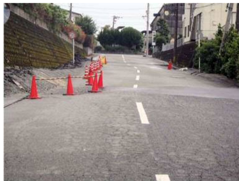
盛土のすべりに押されてセンターラインが湾曲している
