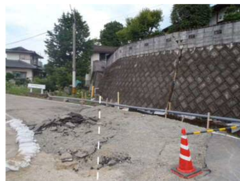
盛土のすべりに押されてセンターラインが湾曲している
