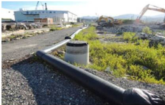
管渠の仮復旧
