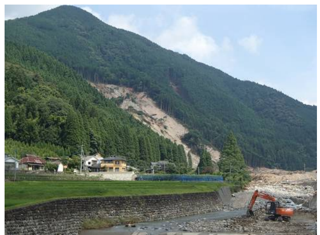
崩壊地の遠景
