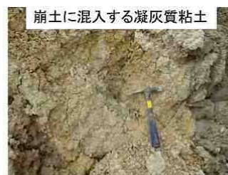
崩土に混入する凝灰質粘土
