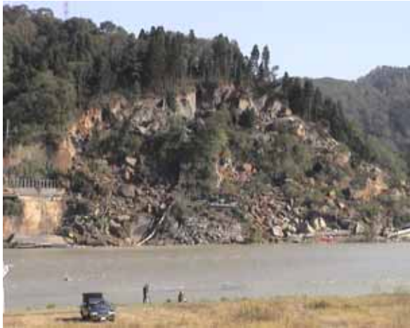
写真2 長岡市妙見町の崩落現場
