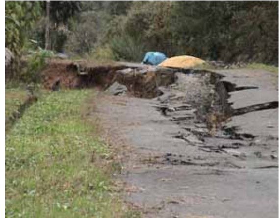
写真4 鶴ヶ丘団地（乙吉町）の谷埋め盛土の最上部。クラックが入っている位置がまさに盛土の境界部に当たる。
