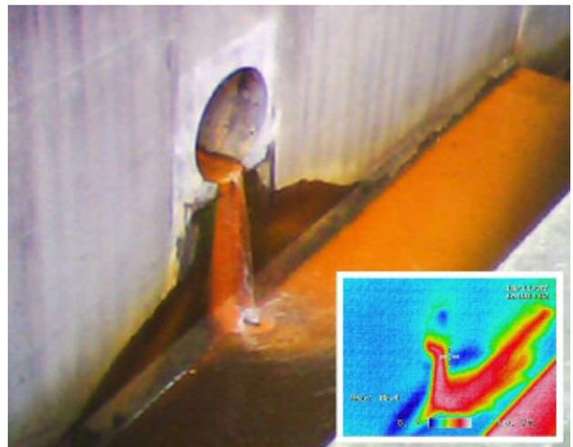
図 5. 敷地の下にあるヒューム管（図 4 の向かって左側の沢を埋めた盛土のため、排水用に設置されている。有馬温泉に近いので、鉄分が多い。地下水になっているため、冬でも暖かい（右下は赤外線写真）。）
