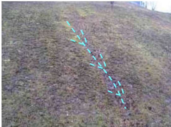
ガリー浸食(表層が雨水で削られている)
