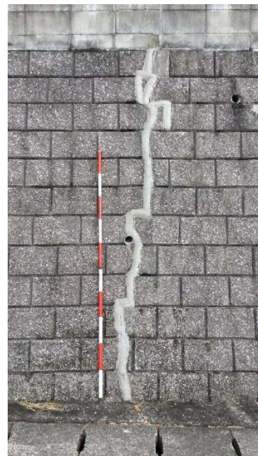
亀裂の充填補修
