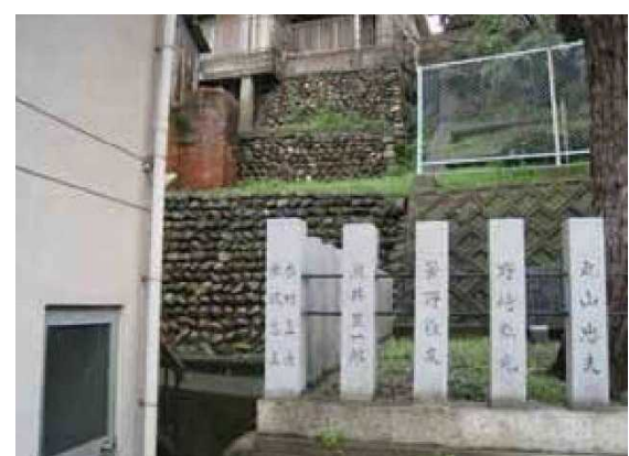
腹付け盛土の空石積み擁壁
