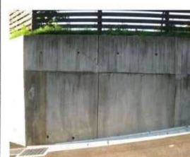
鉄筋コンクリート擁壁
