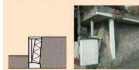
張出し床版付擁壁
