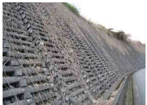
井桁擁壁=湧水が多い
