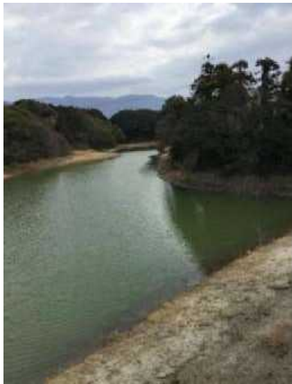
盛土に隣接するため池
