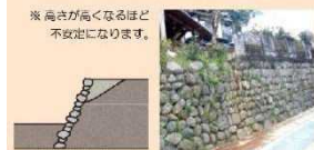
三石積み擁壁
