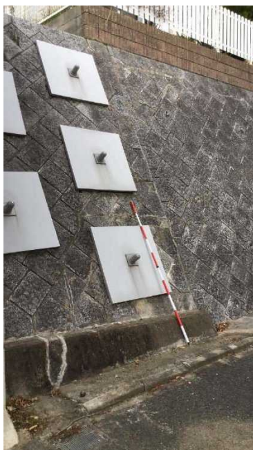
抑止工による補強
