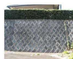
間知ブロック積み擁壁
