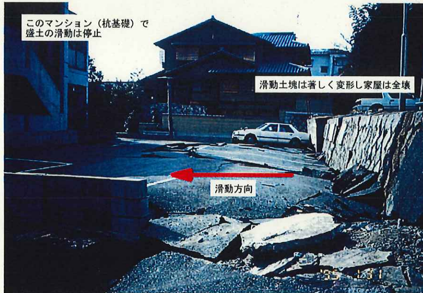
図 4.5.10 区域外への土塊の側方移動は起こらなかったが土塊内は大きく変形した例 (西宮市豊楽町, 1995. 1. 31 釜井撮影)
