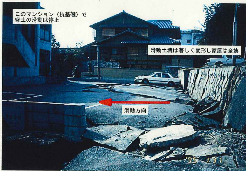
図8.2.1 区域外への土塊の側方移動は起こらなかったが土塊内は大きく変形した例(西宮市豊楽町, 1995. 1. 31 釜井撮影)
