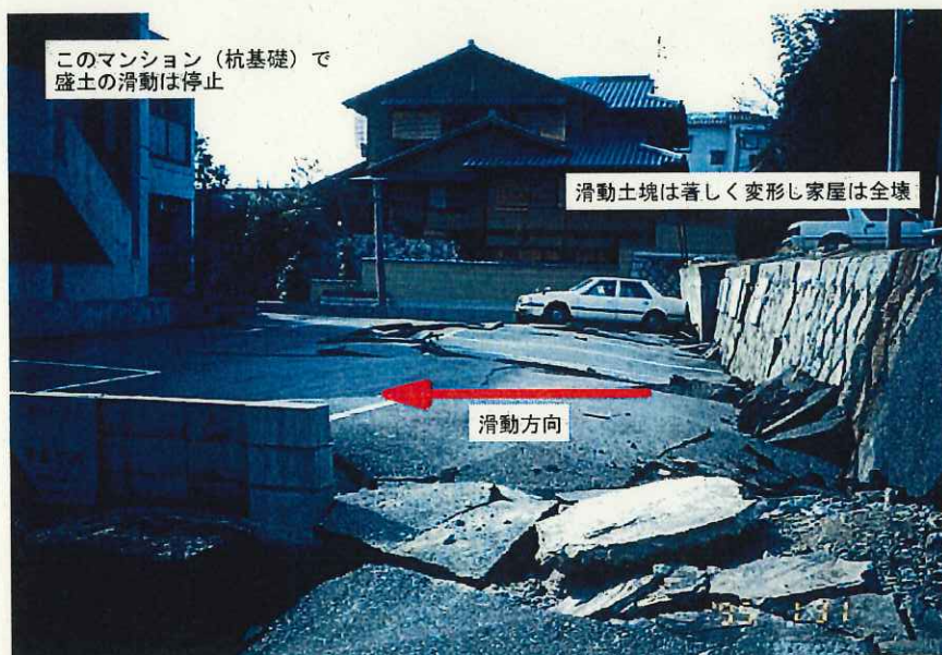
図 4.0.2 区域外への土塊の側方移動は起こらなかったが土塊内は大きく変形した例（西宮市豊楽町，1995. 1. 31 釜井撮影）
