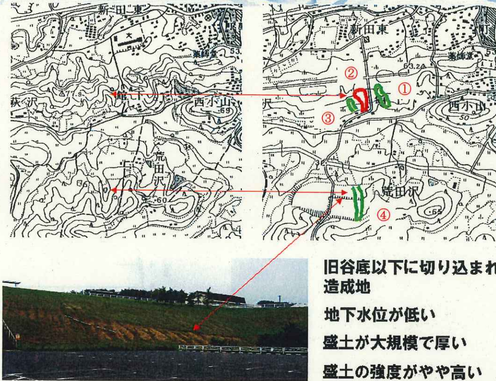
図 3.3.8 築館町における被災状況 (釜井, 2003)
