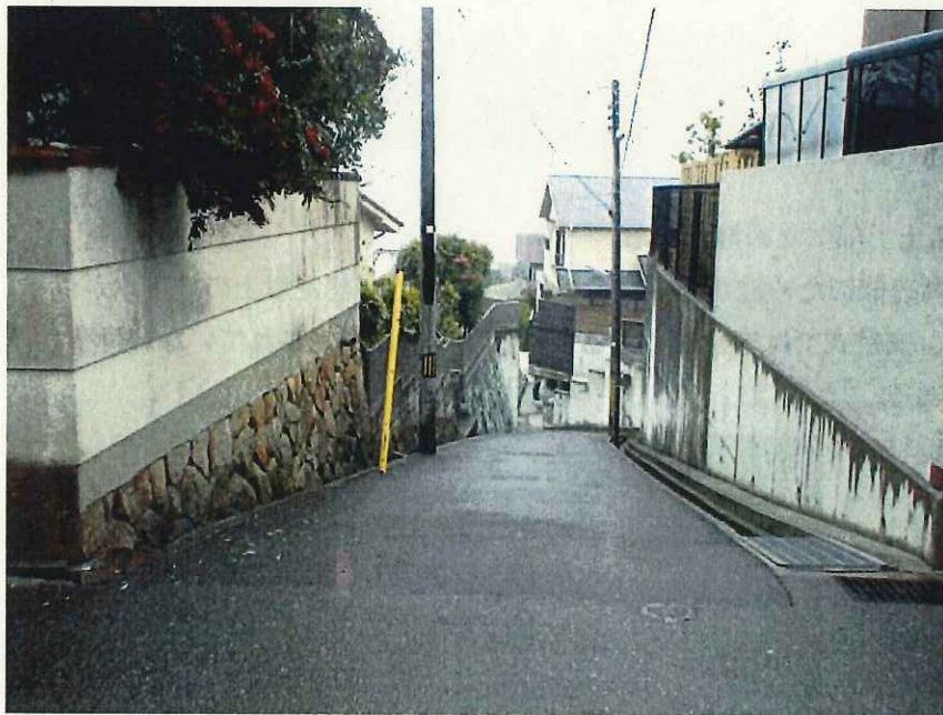
図 2.1.3 盛土の途中から急傾斜となる（芦屋-39）
