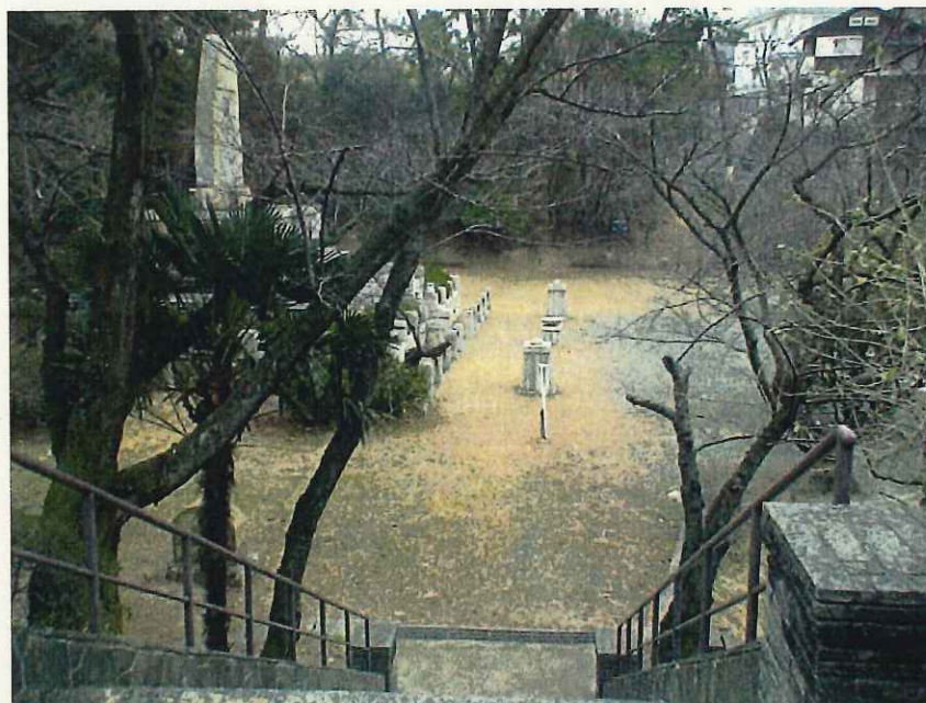
図 2.1.1 かつてため池が上流部分にあった盛土（西宮-10）
