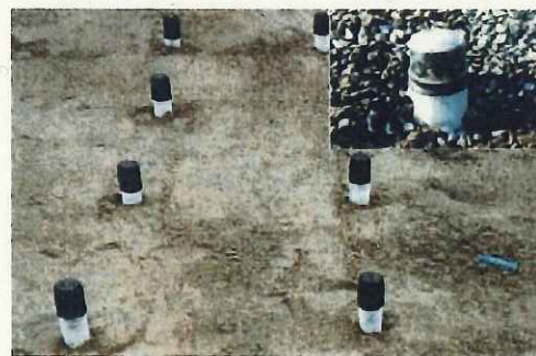
間隙水圧消散工法の例
