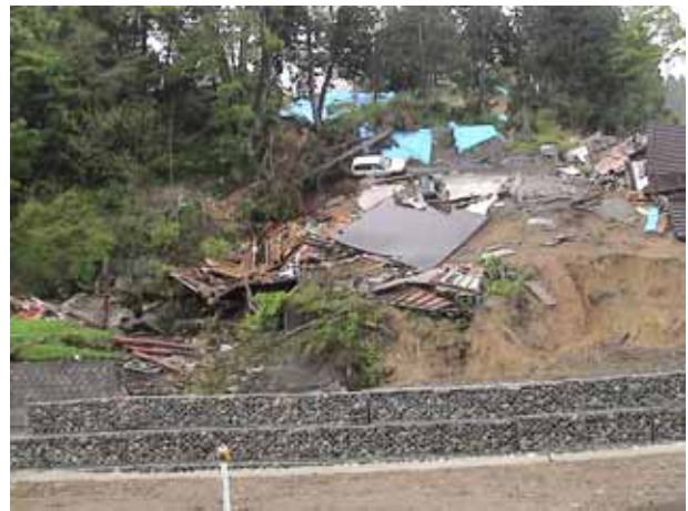
濁沢（地すべりにより2名死亡）
