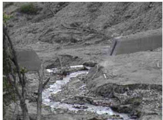
砂防ダムに捕捉された土砂
