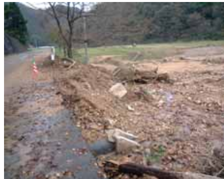
但東町佐々木。土石流が道路を越えて出石川へ流入
