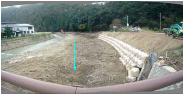
但東町相田地区。橋梁上流部の攻撃側の堤防が破堤。上流から流入した土石が厚く堆積する。
