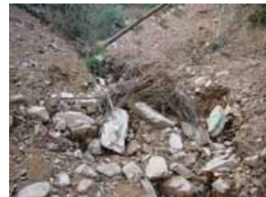
流送部には土石が堆積し、ダムアップしており、流水が多い。
