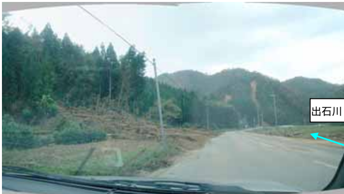
但東町佐々木地区。手前左では土石流により道路・出石川へ流木や土石が流入した。写真奥の山には土石流が2箇所確認される。土石流により流木や土砂は出石側へ流入し、河道閉塞の原因となった。但東町にはこのような箇所が多く見られる。
