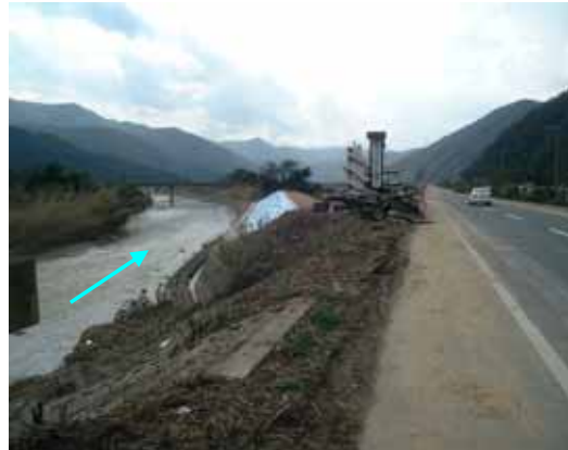
出石町寺坂地区。橋の上流側の右岸が破堤した。
