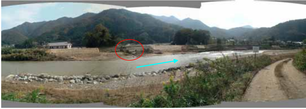
出石町百合地区。丸部には水門があり、周辺の護岸はコンクリートで補強されている。破堤したのは補強していないところ。この場所は彎曲の外側にあたる。
