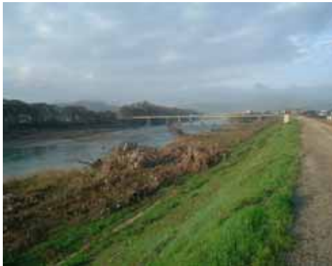
日高町府市場。流木が堤防上まで残る。
