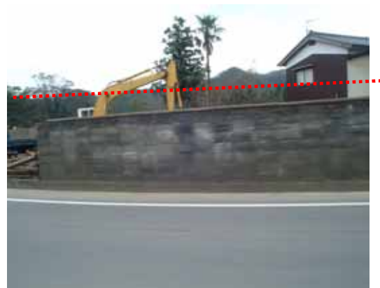
日高町岩中地区。約 2m の浸水があり、損壊した家屋。赤色の線まで増水した。
