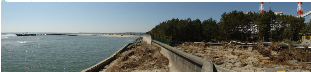
常磐共同火力・勿来発電所（2011.4.1）
