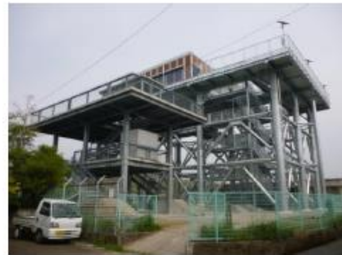
津波避難タワー
