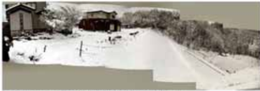
高町4丁目：補強土盛土により復旧されている(2005年12月撮影)。
