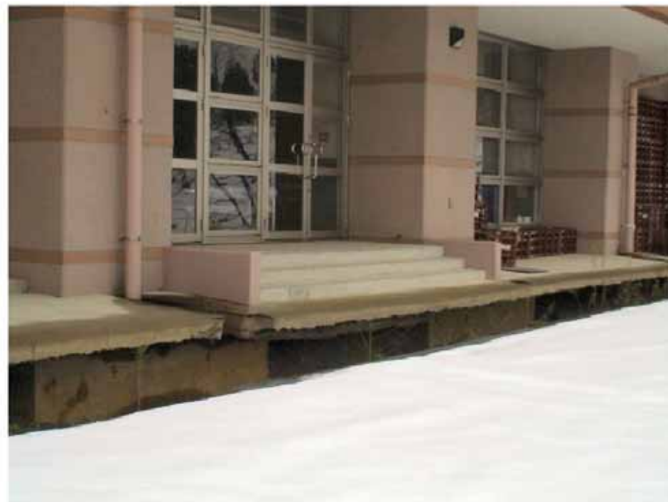
旧山古志村役場の盛土沈下 (34 地点 : 05.12.10)
