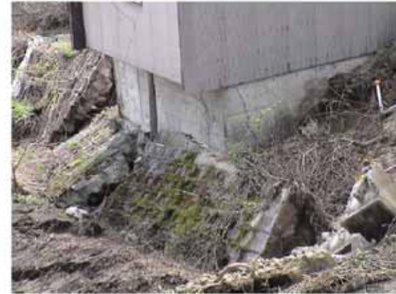
池谷地区, 道路横の急傾斜部の盛土上の の構造物の被災例 (23 地点 : 05. 5. 14)
