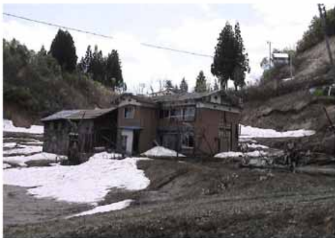
池谷地区。左側の水田が沢埋め土砂部。家屋は大きく変状している。(23 地点 : 05.5.14)
