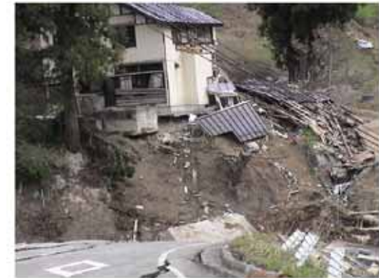
池谷地区家屋. 盛土部の崩壊 (23 地点 : 05. 5. 14)
