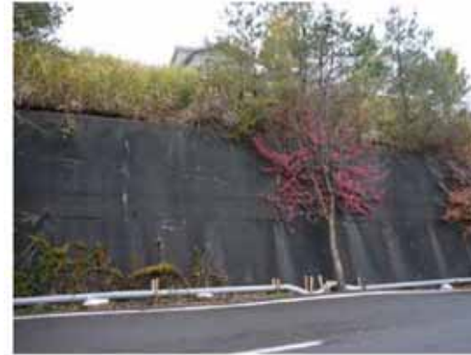
擁壁の割れ目から流出する地下水 (高町団地) (66 地点 : 04.10.31)
