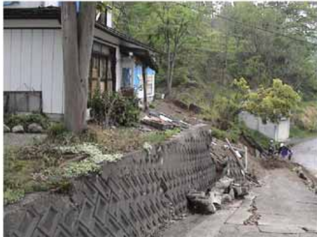
典型的な宅地の地震被害. 擁壁などの急斜面 部は容易に破壊され崩壊している. 2005 年 12 月には, 家屋は全て撤去されていた. (53 地点 : 05. 5. 15)
