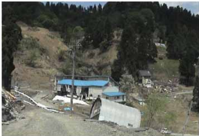
池谷地区。青い屋根の建物が沢の堆積物と考えられる。(23 地点 : 05.5.14)
