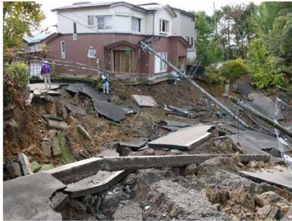
高町団地における谷埋め盛土崩壊の頭部 (67地点：04.10.31)
