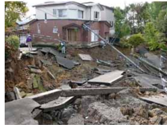
高町団地における崩壊 A の頭部 (67 地点 : 04.10.31)
