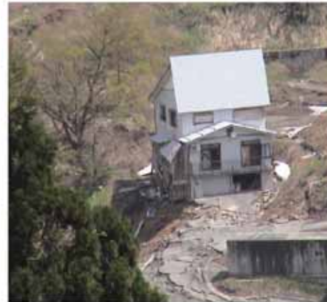
楢木集落内の斜面肩部の崩壊 (05. 5. 14)
